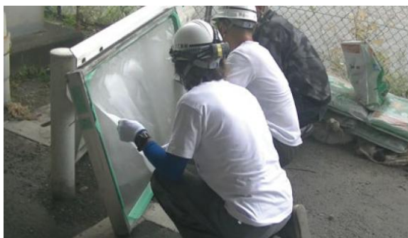
STEP3 専用シート貼付け
