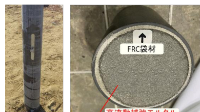
FRC補強完了
