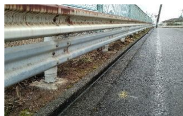
⑥ 施工完了
