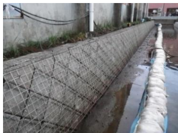
ブロック積護岸
