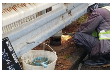
① 支柱切断
