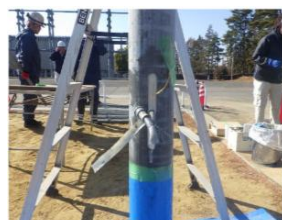
充填完了後、注入ホース封止
