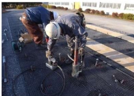
④ 拘束部材先端部拡大
