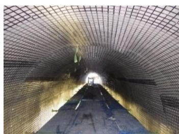
幹線水路トンネル
