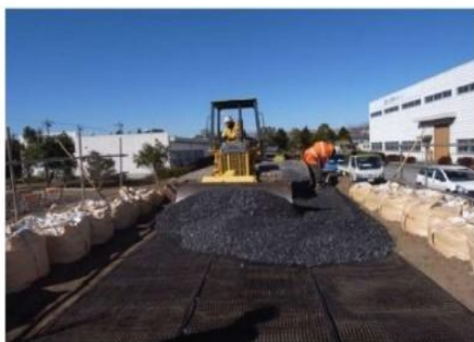
② 粒状層の施工
