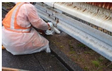
③ 補強材の挿入
