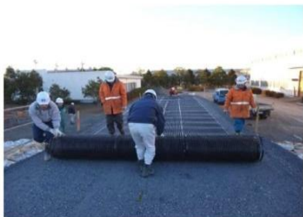
① ジオグリッドの敷設
