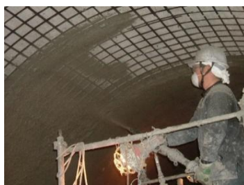
水路トンネル
