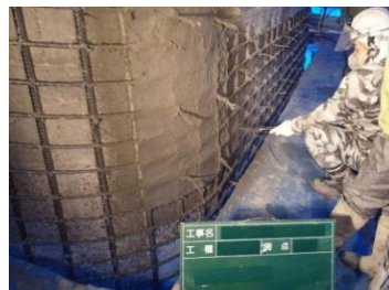
橋脚耐震補強
