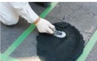
STEP5 敷き均し
