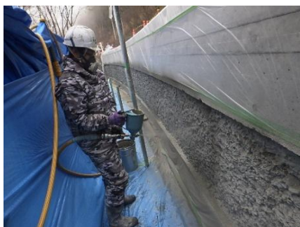
複合劣化抑制ペースト塗布状況
