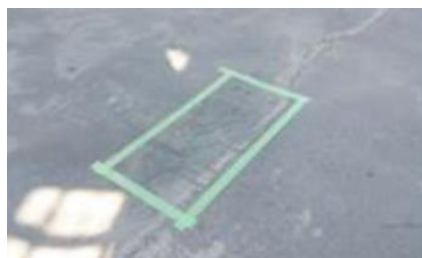
STEP1 施工範囲の養生
