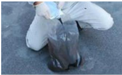
STEP2 骨材袋に樹脂を投入
