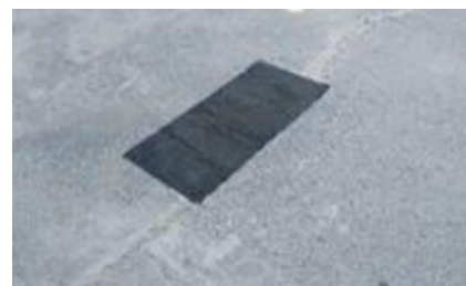
STEP6 施工完了
