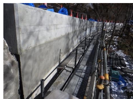
Extended-SSI工法完了
