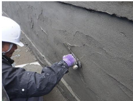
遮塩モルタル左官状況
