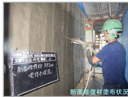
遮塩モルタル吹付状況
