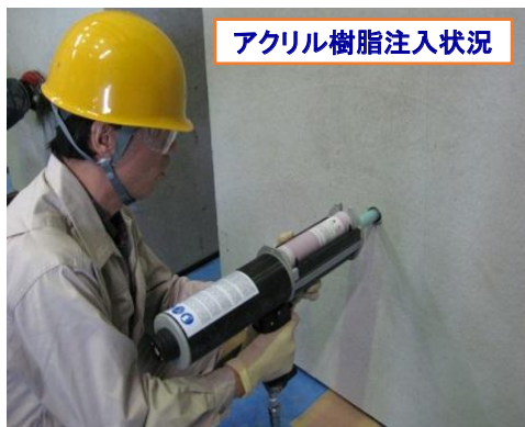
アンカーボルト挿入状況
