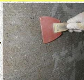
シート貼り付け
