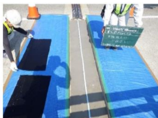
②下地調整工
