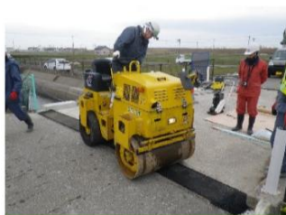
⑧表層敷設・仕上げ
