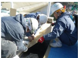
④ラッピングシート貼付(下層)
