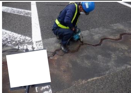
STEP1 既存止水材撤去
