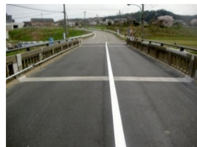
⑥施工完了
