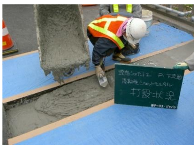
④高靱性ジェットモルタル(R)打設
