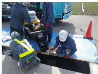
⑤ブチルゴム合材敷設
