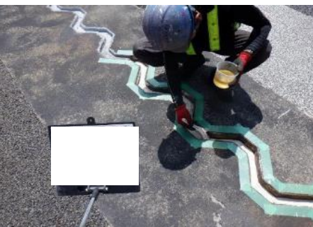
STEP5 プライマー塗布 標準塗布量：0.15kg/m 2
