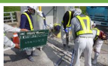
旧ジョイント撤去・はつり
