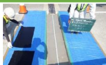
既設撤去・下地調整・止
