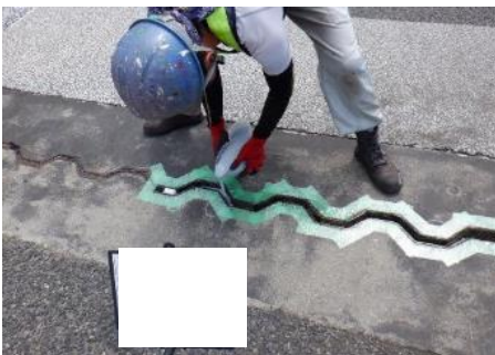
STEP6 止水材塗布 標準塗布量：39.0kg/m 2
