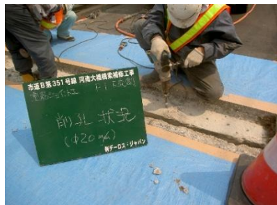
②削孔・アンカー定着
