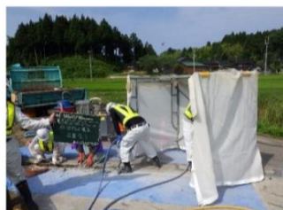
①既設伸縮装置撤去
