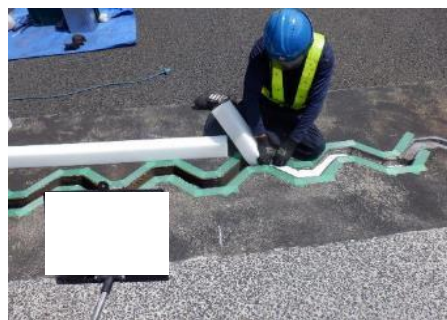
STEP3 バックアップ材設置
