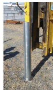
打ち込み完了
