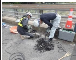
①既存舗装除去
