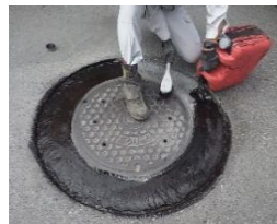
②加熱溶融シート or アスファルト乳剤敷設 ③Eco路面リペア敷均し
