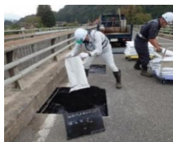
②Eco路面リペア敷均し
