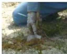
杭内部の砂のかき出し
