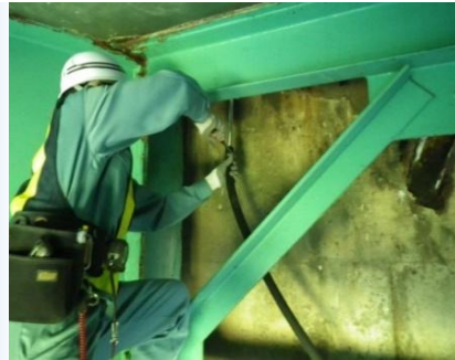
流末配管状況
