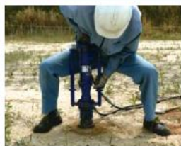
打ち込み完了
