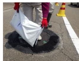
②加熱溶融シート or アスファルト乳剤敷設 ③Eco路面リペア敷均し
