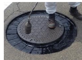
②加熱溶融シート or アスファルト乳剤敷設 ③Eco路面リペア敷均し
