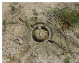
プレートくい内部の状態
