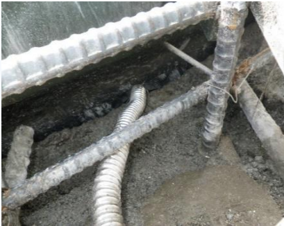
排水パイプ周辺確認
