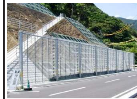
道路脇設置事
