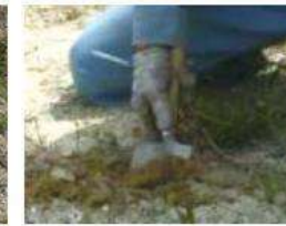
杭内部の砂のかき出し
