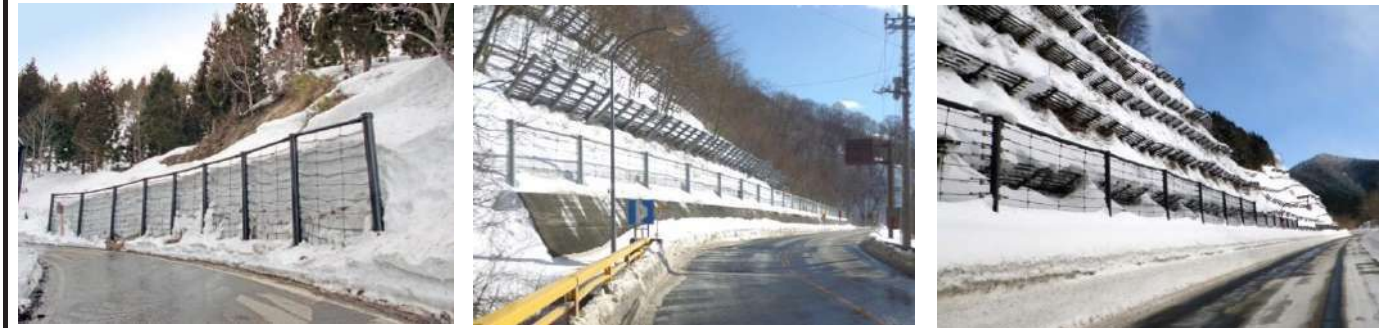
道路脇設置事
