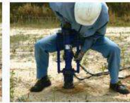
打ち込み完了
