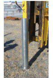
打ち込み完了
