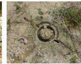
プレートくい内部の状態
